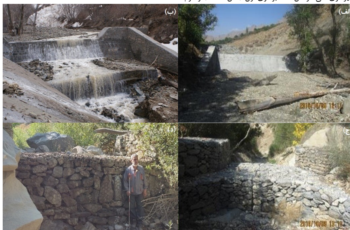
شکل ۳- وضعیت سازه‌های آبخیزداری مسیل سیجان: الف- بند سنگی ملاتی در زمان نقشه‌برداری فاز اول (۱۳۹۷)، ب- بند سنگی ملاتی در فرودین ۱۳۹۸ پس از رخداد سیل، ج- بند گابیونی دوم در زمان نقشه‌برداری فاز اول، و د- بند گابیونی دوم در زمان نقشه‌برداری فاز دوم (۱۴۰۰)
