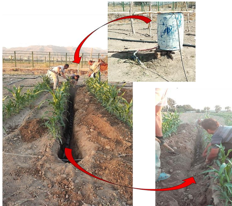
شکل ۴- کارگذاری لوله در عمق ۰/۵ m و اتصال به منبع آب و عمودی قرار دادن فیتیله‌ها کنار ریشه‌ها و پرکردن شیار Fig. 4 Placing the pipe at a depth of 0.5 m and connecting to water reservoir and setting the wicks vertically next to the roots of the plants and filling the furrow
